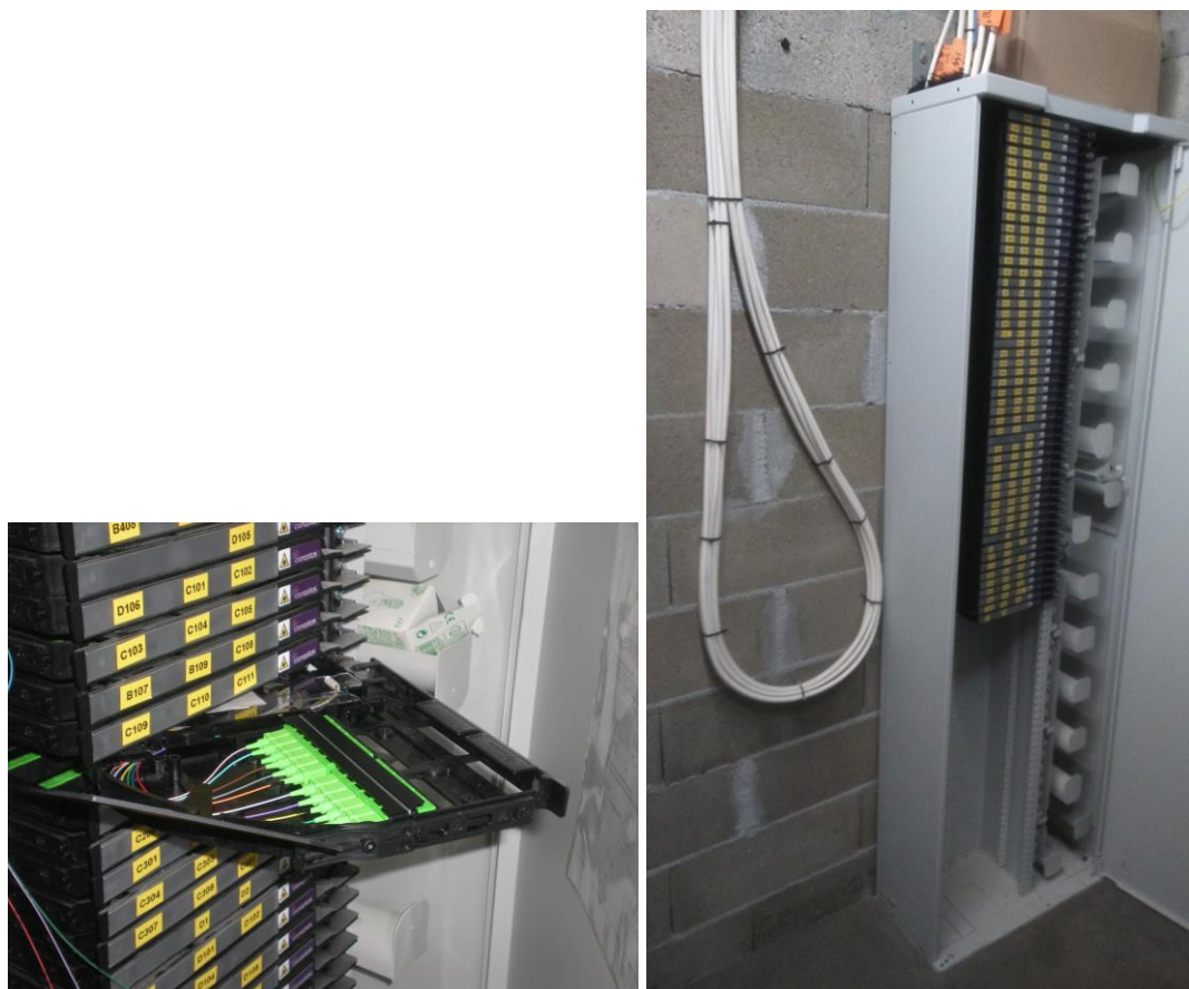
Figure 6 : PMI de la marque Idéa Optical, format ETSI.
