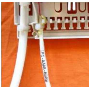
Figure 14 : étiquette enroulée sur le câble de branchement
