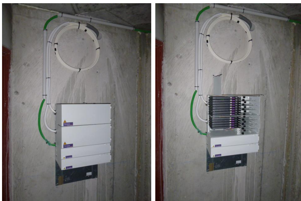
Figure 7 : PMI de la marque Idéa Optical, modulaire.
