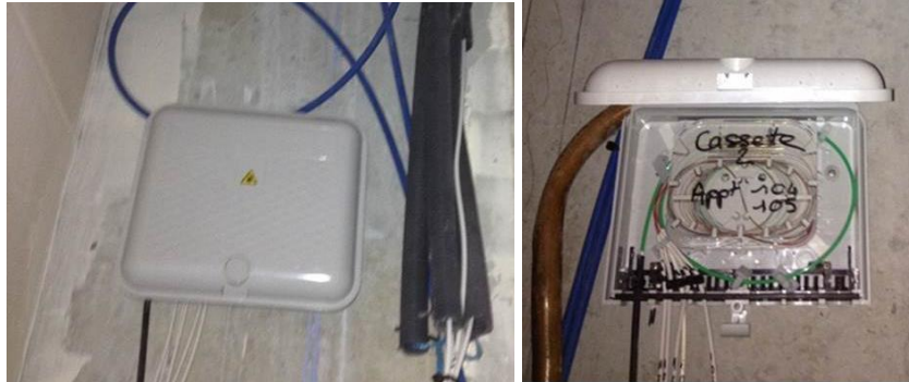
Figure 10 : PB 3M 2 cassettes de 12 soudures possibles
